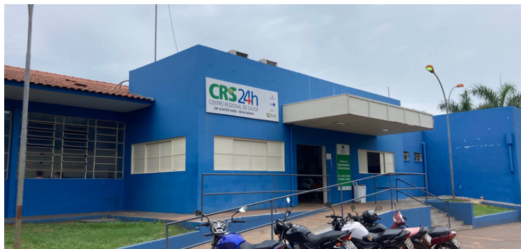
Foto 1- Fachada do centro de saúde Nova Bahia
