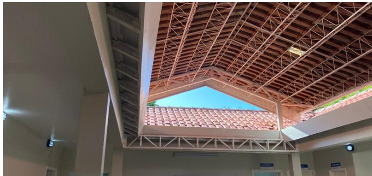
Foto 5 - Telhado da unidade com abertura, facilitando entrada de água
