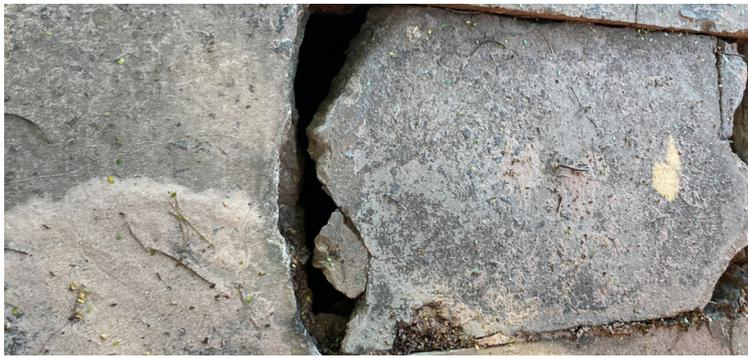
*Foto 9 - Tampas da rede de esgoto encontram-se quebradas*
