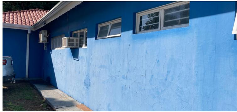
*Foto 10 - Fissuras se propagando nas paredes externas da unidade*
