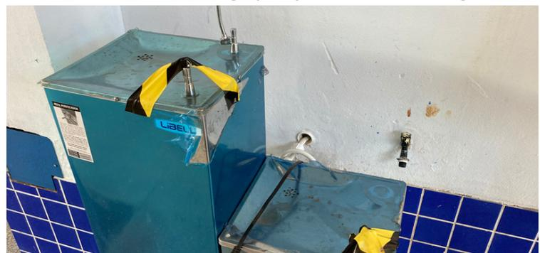
Foto 18 Bebedouro sem tomada
