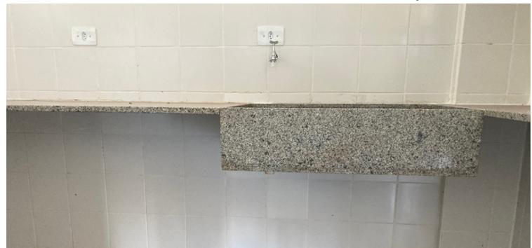
Foto 16 Pia sem ligação para vazão de água
