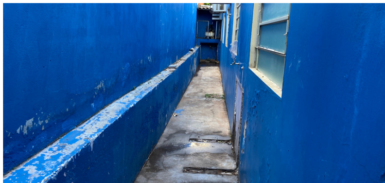
Foto 3 Corredor atrás da unidade
