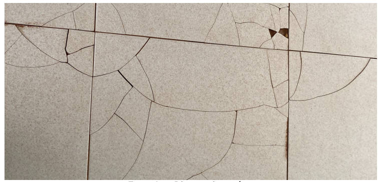
Foto 2 - Pisos trincados
