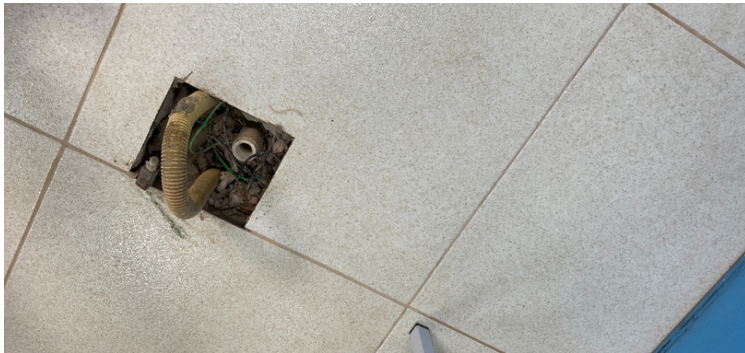
Foto 7 - Fiação instalada para fixação de cadeira odontológica
