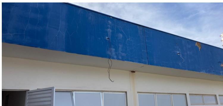
Foto 8 - Avarias na estrutura e incorreta drenagem dos ares condicionados
