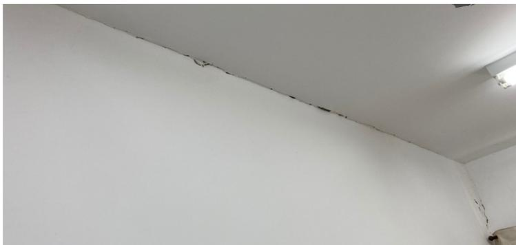
Foto 3 - Fissuras se alastrando na estrutura de toda unidade
