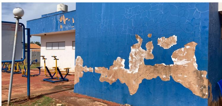
Foto 6 - Deterioração da fachada da repartição
