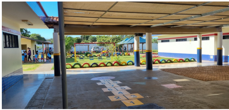
Foto 1 - Área externa da unidade reestruturada com cobertura e pavimentação
