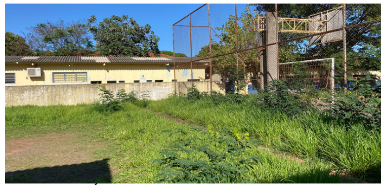
Foto 2 - Área verde do centro necessitando da devida manutenção.
