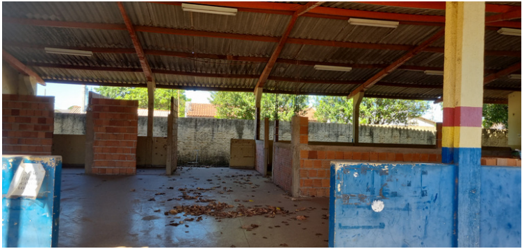
Foto 3 Parte interna da obra parada.
