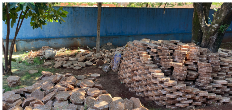
Foto 8 - Pedras hexagonais dispostas na área externa para futuro calçamento.
