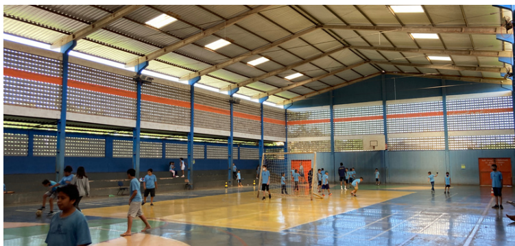
Foto 4 - Necessidade de revitalização da quadra de esportes.
