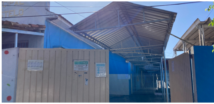
Foto 1 Fachada da Escola Municipal Geraldo Castelo.
