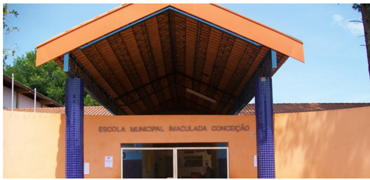
Foto 1 Fachada da Escola Municipal Imaculada Conceição.
