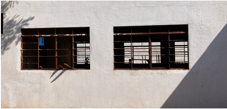
Foto 11 Sala aos fundos da escola onde a construção não foi concluída desde 2012.
