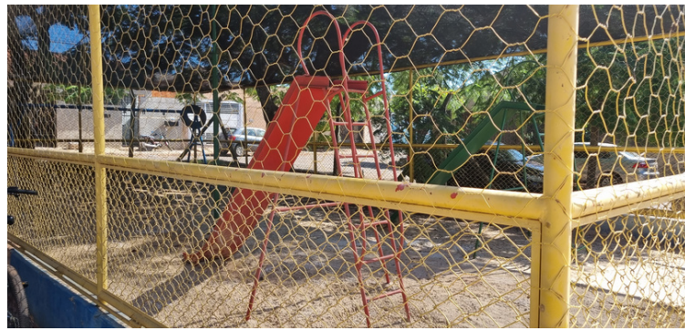
Foto 2 Parquinho interditado aguardando manutenção.
