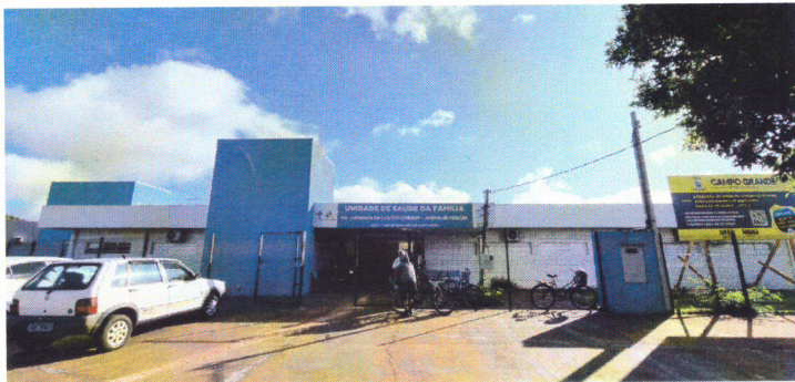
Foto 1 Fachada da USF Dr. Dr. Jurandyr de Castro Coimbra - Zé Pereira.
