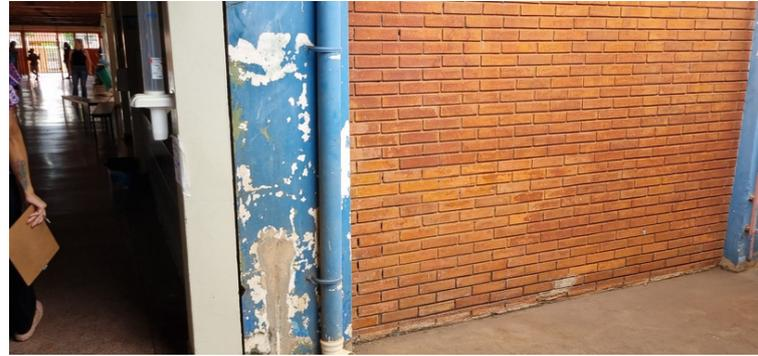
Foto 4 Pintura danificada na parede.
