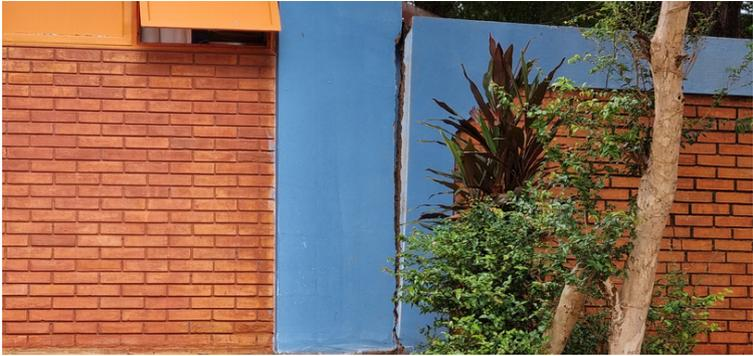
Foto 3 Muro ao lado das salas de aula com rachadura espessa.
