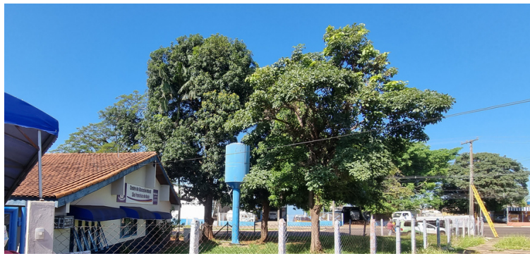
Foto 1 Fachada da EMEI São Francisco de Assis.
