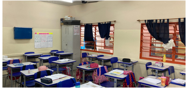
Foto 4 Salas de aulas sem climatização adequada.
