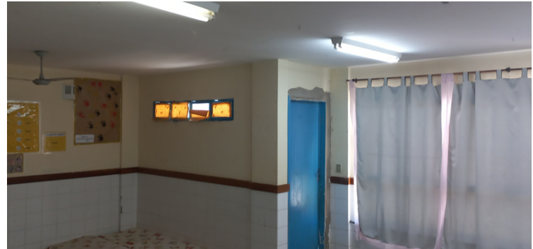
Foto 4 Determinadas salas passaram por reforma, restando a pintura para finalização.
