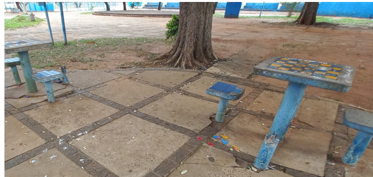
Foto 4 Mesa e bancos quebrados revelando a falta de manutenção.
