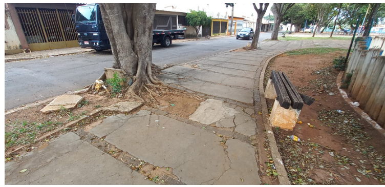
Foto 2 Raízes de árvores danificando a calçada por todo o entorno da praça.
