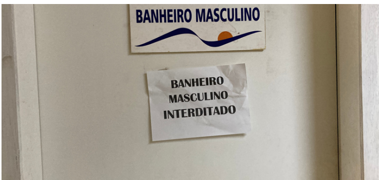
Foto 7 Banheiro interditado por falta de manutenção.
