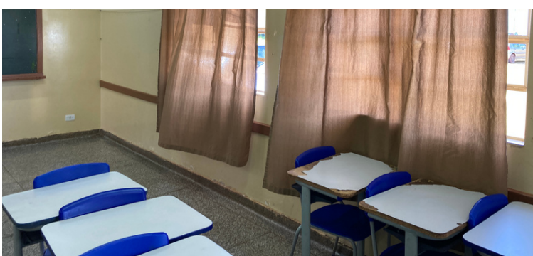
Foto 7 Mobiliário do corpo discente desgastados e insuficientes.
