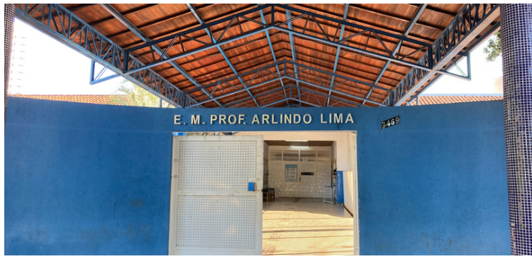
Foto 1 Fachada da EM Prof. Arlindo Lima.
