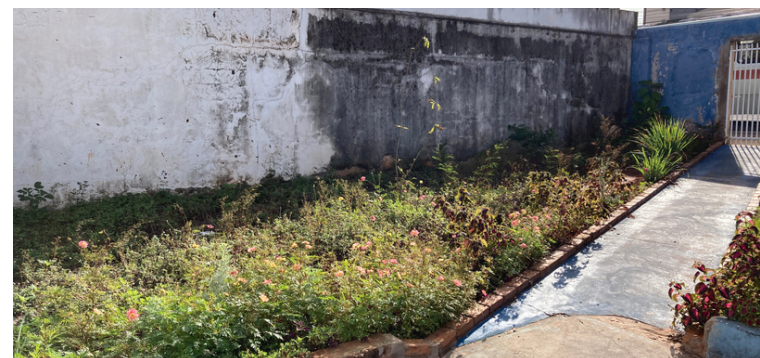
Foto 8 Área verde sem a devida manutenção.
