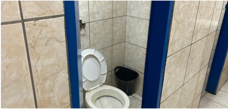
Foto 3 Banheiro isento de manutenção na rede hidráulica.
