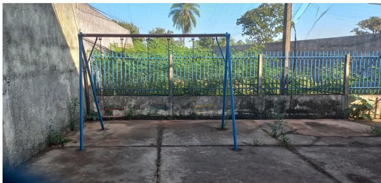
Foto 11 Parquinho inutilizado por estar instalado em área que representa risco às crianças.
