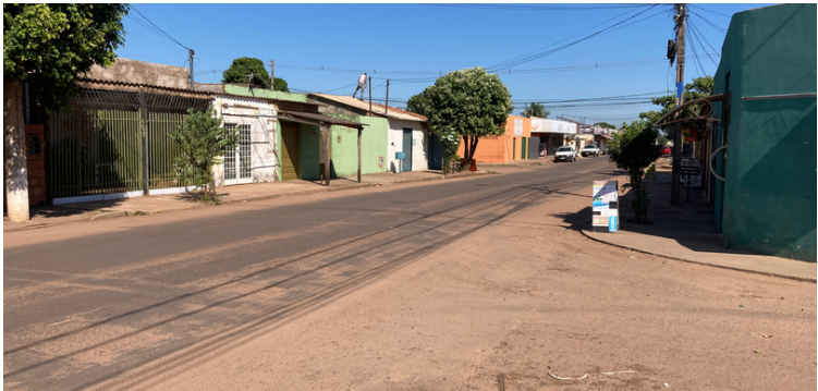
Foto 13 Local para instalação de redutor de velocidade.
