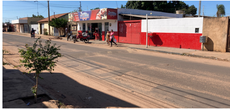
Foto 12 Rua Mansour Contar localizada ao lado da EM. Valdete Rosa da Silva necessita de instalação de redutor de velocidade.
