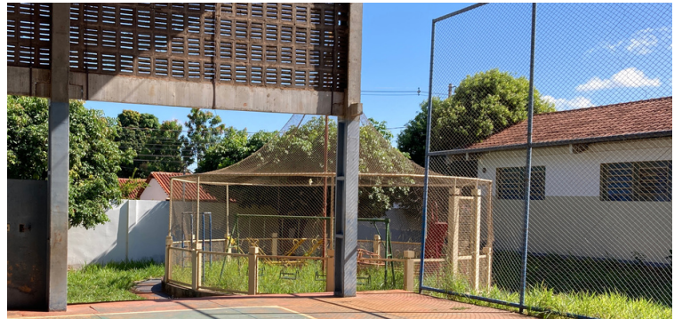
Foto 6 Parquinho interditado por conta de areia contaminada.
