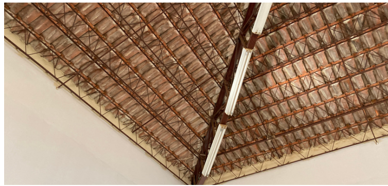
Foto 4 Estrutura reformada, impossibilitando a entrada de água e aves.
