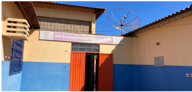
Foto 1 Fachada da EMEI Engenheiro Valdemir Correa de Resende
