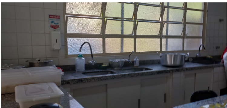
Foto 3 Cozinha devidamente estruturada, equipada e provida.
