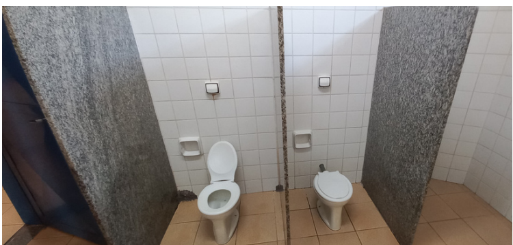
Foto 5 Banheiros em boas condições de uso e bem conservados.
