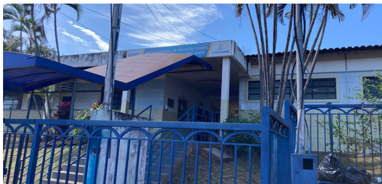
Foto 1- Fachada da EMEI Lúcia Ângela de Castro Costa.
