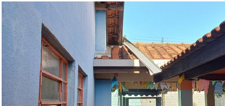
*Foto 10 Calha estragada, necessitando de conserto.*
