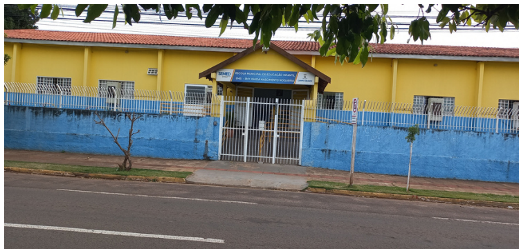
Foto 1 Fachada da Emei Emy Ishida Nascimento Nogueira, necessitando revitalização na pintura e faixa elevada para travessia de pedestres.
