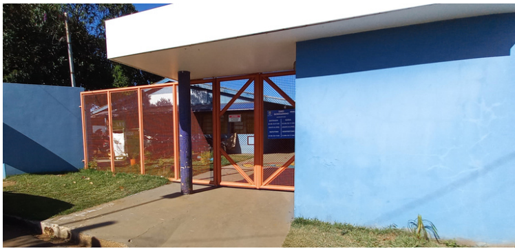
Foto 1 Fachada da EMEI Serradinho.
