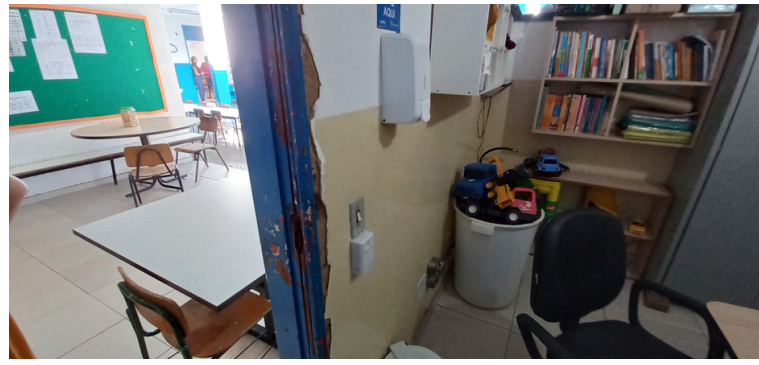
Foto 10 Porta da sala da coordenação estragada por ter sido arrombada por ladrões.
