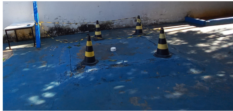
Foto 4 Fossa instalada no pátio de brincadeiras.
