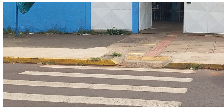
Foto 2 Necessidade de rebaixamento de meio fio e construção de faixa de pedestre elevada.
