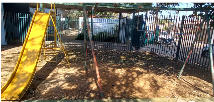
Foto 14 Parquinho infantil com brinquedo quebrado.
