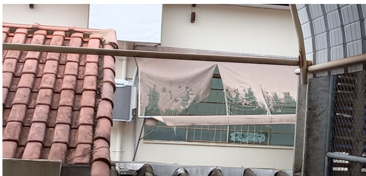
Foto 7 Toldo deteriorado.
