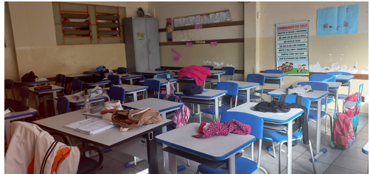
Foto 6 Salas de aula sem climatização.
