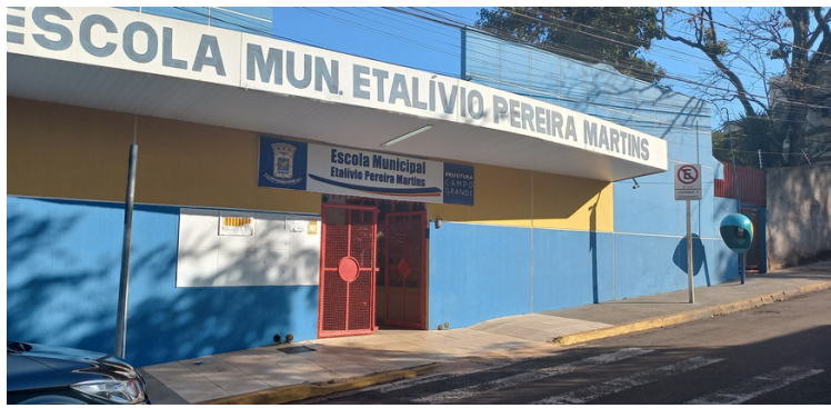
Foto 1 Necessidade de faixa de pedestre elevada.
