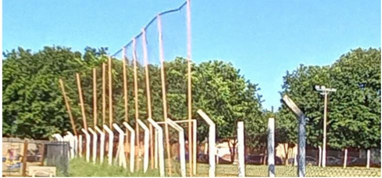
Foto 4 Grade de proteção do campo de futebol com risco de cair
