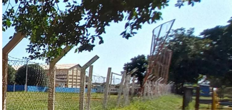
Foto 3 Grade de proteção do campo de futebol com risco de cair.
