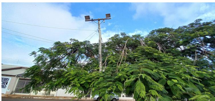
Foto 7 Árvore encostando na rede elétrica.
