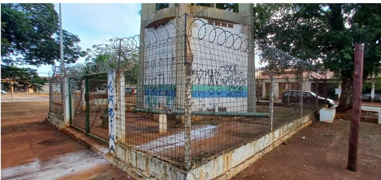
Foto 6 Caixa d'água com a estrutura completamente danificada por ferrugem e pichações.
