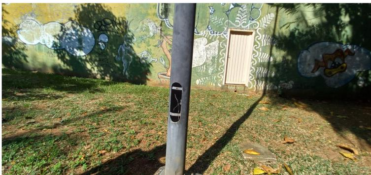
*Foto 6 Poste sem tampa de proteção restando a fiação exposta.*
