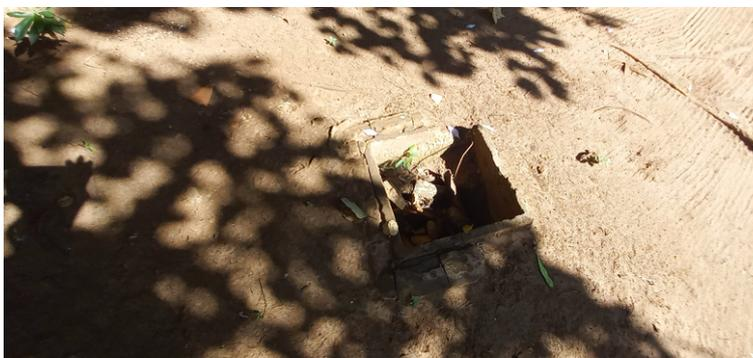
*Foto 4 Ausência da tampa na caixa de passagem, causando riscos de acidentes.*
