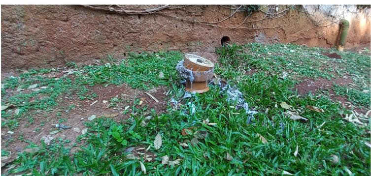
*Foto 7 Extravasamento de esgoto doméstico no terreno da praça.*
