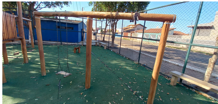
Foto 5 Brinquedo do parque infantil necessita de reparos.
