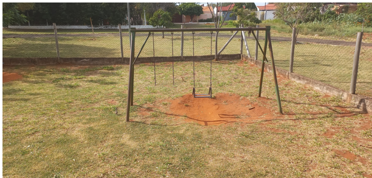
Foto 5 Determinados brinquedos danificados, necessitando manutenção.
