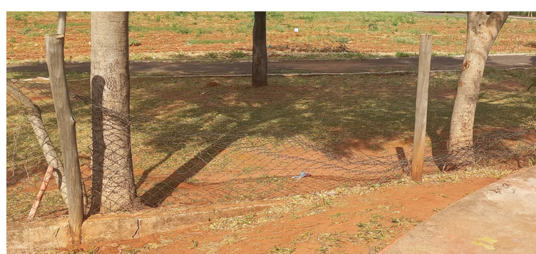
Foto 8 Grades de proteção avariadas.
