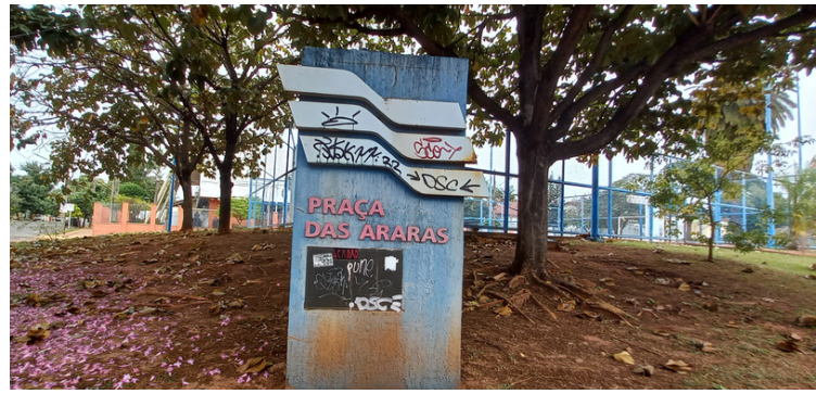
Foto 2 Monumento com nome da praça danificado.
