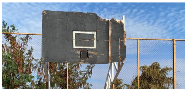
Foto 8 Tabela de basquete deteriorada.
