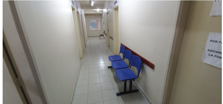
Foto 4 Corredor de acesso aos consultórios.
