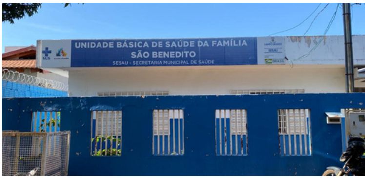
Foto 1 Fachada da UBSF São Benedito.
