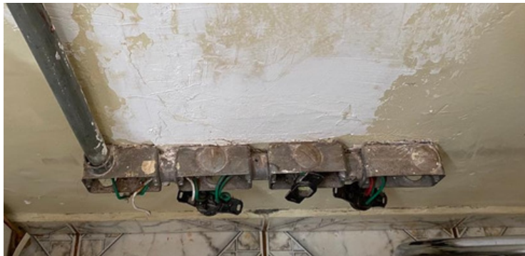
Foto 11 Tomadas e fiação elétrica aparente.
