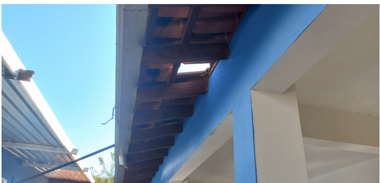
Foto 11 Precisão da substituição de telhas quebradas.
