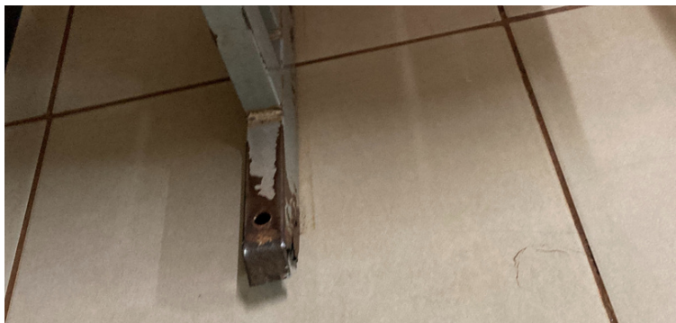
Foto 6 Estrutura de sustentação das cadeiras da recepção enferrujadas e com pontas.
