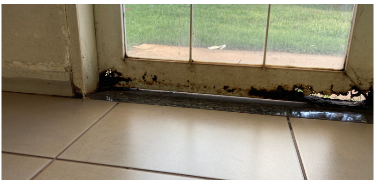
Foto 13 Portas corroídas por ferrugem
