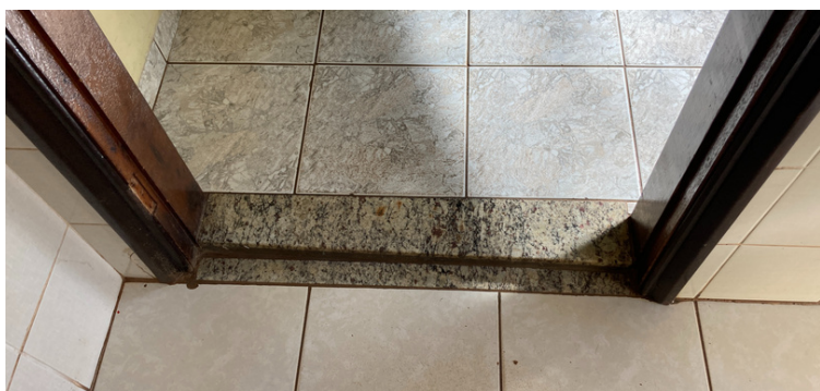
Foto 14 Degraus nas portas, o que dificulta o trânsito de cadeirantes na parte interna da unidade.
