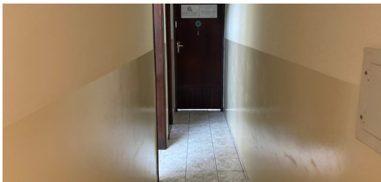
Foto 12 Corredores e portas estreitos, o que dificulta a locomoção de cadeirantes dentro da unidade.
