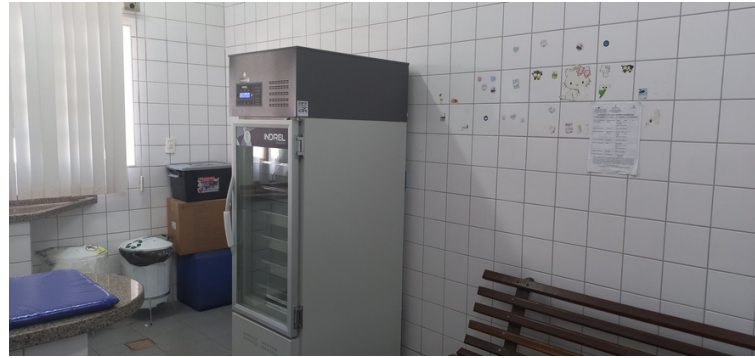
Foto 8 Vacinas devidamente acondicionadas na câmara fria.
